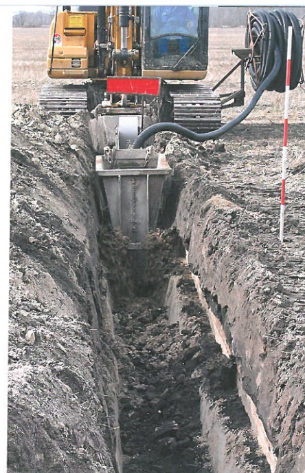
■ Her ses den traditionelle dræningsmetode med gravemaskine og efterfølgende drænkasse, som lægger grus ned.
